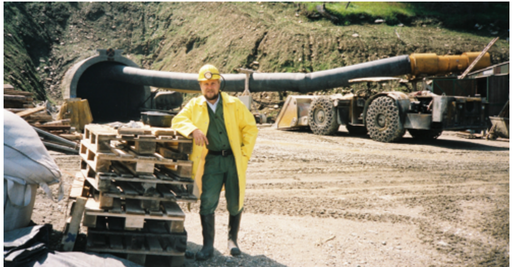
Oben: Der Verfasser vor dem Eingang des Stollenmundlochs. Unten: Stollenanschlag des Traudi Stollens im Jahr 1985. Fotos: R. Göd
